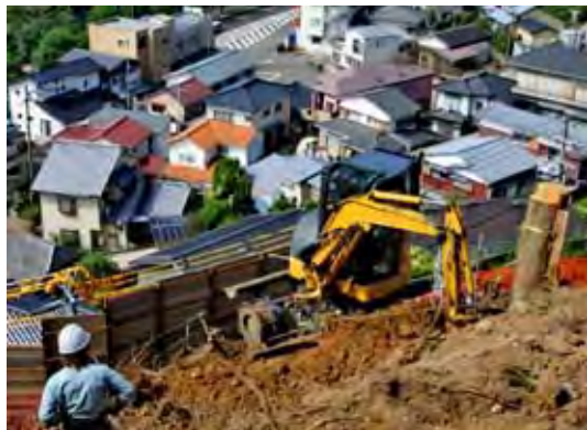
▲現在は住宅密集地で施工中（滑石3丁目（4）地区）
