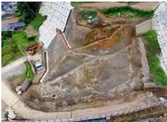
▲複雑な法面掘削を丁張レスで実現（中ノ場（3）地区）
