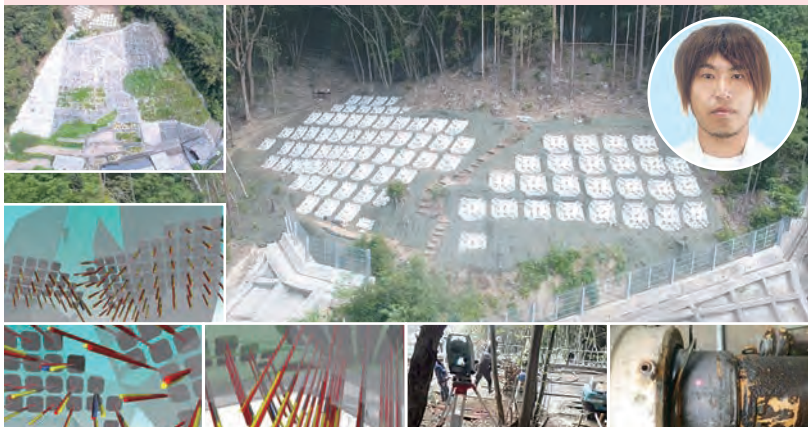
アンカー内部の3次元化による内部状況確認 (黄：設計、青：掘削方向変更、赤：施工後)
