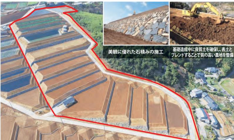
美観に優れた石積みの施工    基礎造成中に良質土を確保し、表土とブレンドすることで質の高い農地を整備
