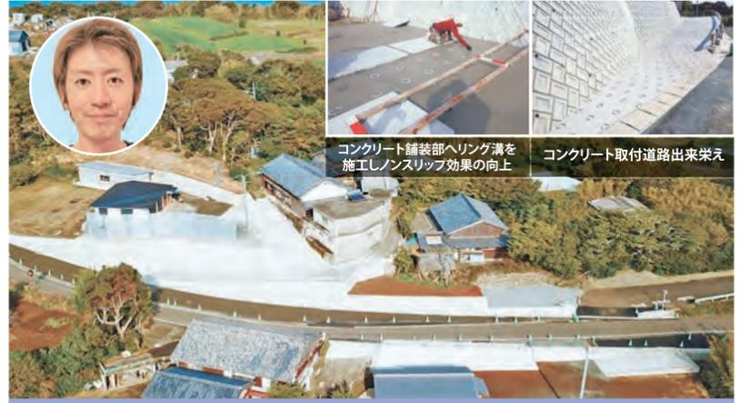
コンクリート舗装部へリング溝を施工しノズリップ効果の向上    コンクリート取付道路出来栄
