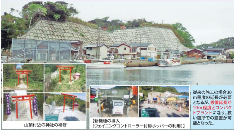
従来の施工の場合30m程度の延長が必要となるが、設置延長が10m程度とコンパクトプラントになり、狭い箇所での設置が可能となった。
