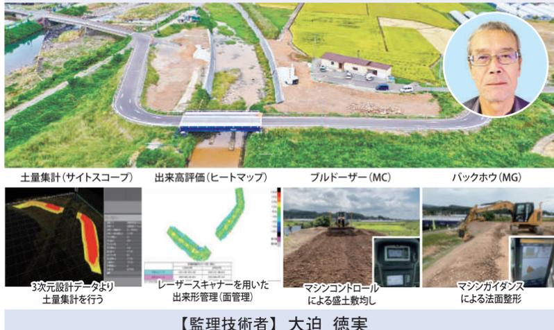
土量集計(サイトスコープ) 出来高評価(ヒートマップ) ブルドーザー(MC) バックホウ(MG)
